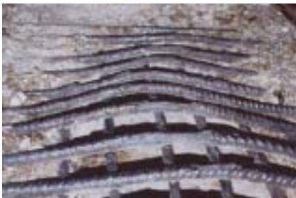
鉄筋コンクリート壁
